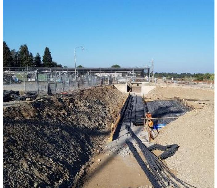
**FUTURE FISH VIEWING SITE – UNDERWATER WINDOWS WILL BE ON THE RIGHT SIDE OF THE FLUME. BEYOND IS THE OPENING INTO TOP OF THE EXISTING FISH LADDER.**
